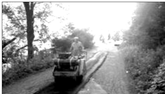
Oprava cesty Zahuru
