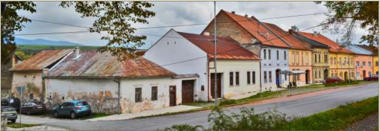
typické súvislé domoradie radových meštianskych domov na ulici SNP č. 15 - 20 - na začiatku stojí dom s voľným prejazdom ľudového charakteru - SNP č. 14 - jednotraktový s typickou hmotovo masívnejšou stavbou murovanej sýpky v polohe dvorového krídla (úplne vľavo), do ulice má strechu ukončenú valbou
