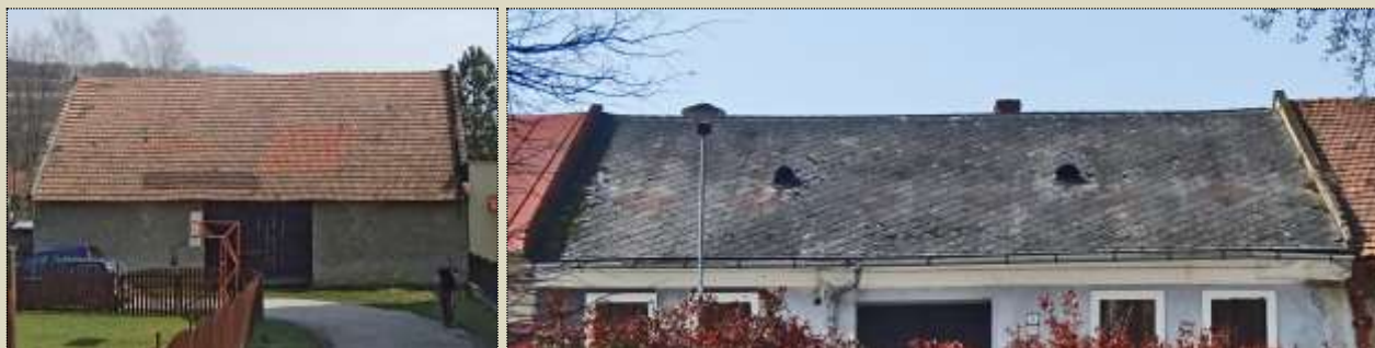
lokálne obmieňaná razená škridla s plytkým dvojžliabkovým profilom na tradičnej stodole a eternitová diagonálne kladená krytina s už ťažko čitateľným tradičným kladačským vzorom
