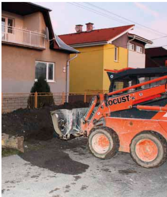
Oprava kanálovej šachty na ul. Kukučínovej
