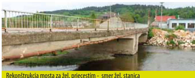
Rekonštrukcia mosta za žel. priestestím - smer žel. stanica
