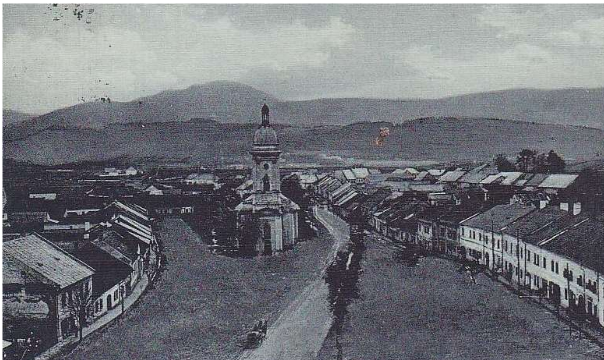
pohľad na južnú časť PZ - z prelomu 19. a 20. storočia - na pohľadnici vidieť travertínové chodníky pri domoradiach, zrejme spevnenú / štetovanú cestu s kaleným povrchom a nečlenené plochy námestia - vpravo za uličnou zástavbou Kostolnej vidieť súvislý rad ukončujúcich stodôl na dnešnej Včelnej ulici
