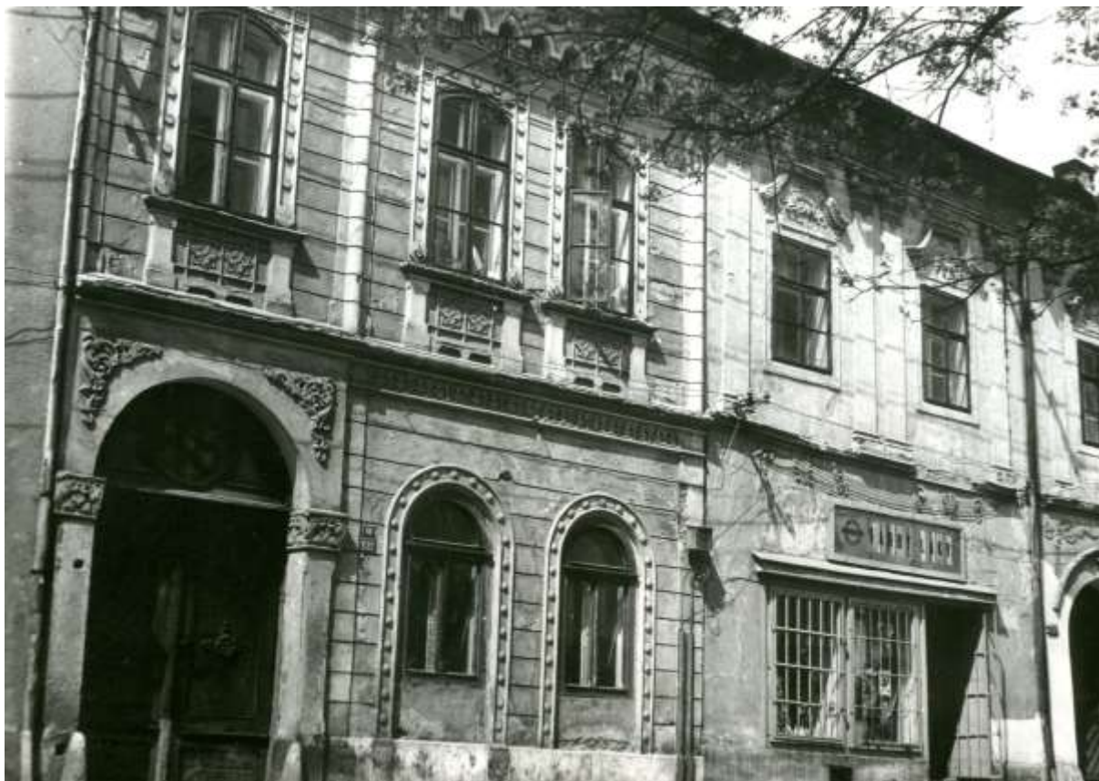
NKP meštianske domy na Kostolnej ul. č. 37 a 38 - fotografia z r. 1976, zdroj: archív PÚ SR
